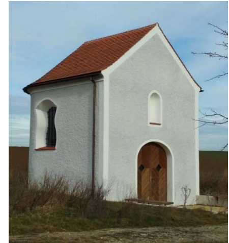
Wieskapelle 2020, nach Renovierung
